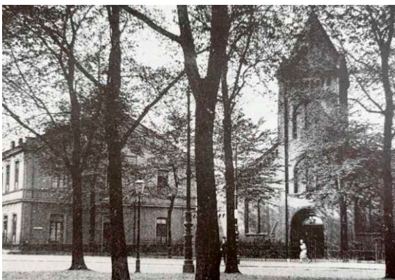
Bild: Katholische Kirche St. Maria Bei der Reitbahn 4, mit dem Platz „Reitbahn“, Anfang des 20. Jahrhunderts
